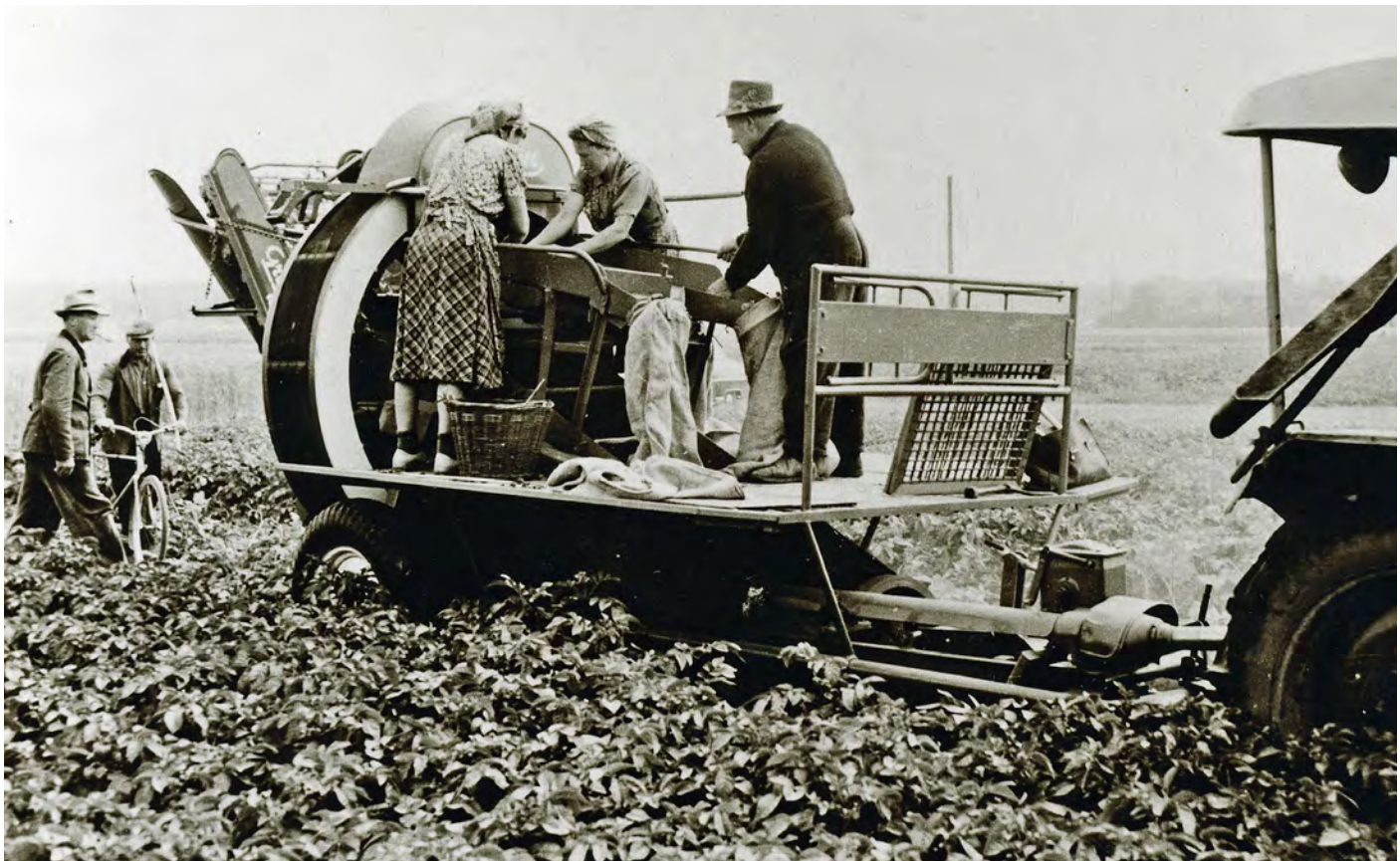
Die Universal mit Plattform und Trichter zum Befüllen der Kartoffelsäcke im Einsatz am Niederrhein.
